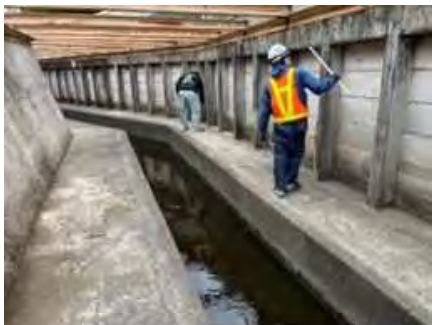
変状調査(点検)
