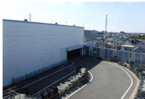
中央JCT南側ランプシールド防音設備設置状況 (令和4年9月27日)
