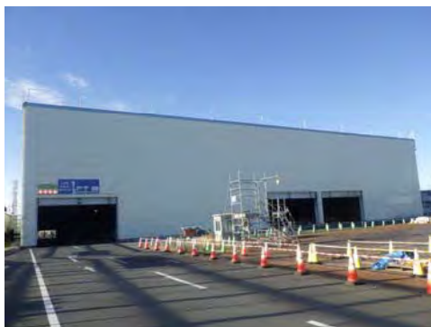
土砂ピットヤードの状況 (令和6年11月29日)
