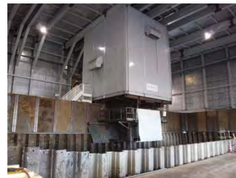
土砂ピットヤード内部の状況 (令和6年11月29日)
