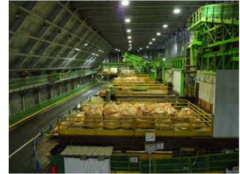
土砂ピットヤード内部の状況 (令和6年12月5日)
