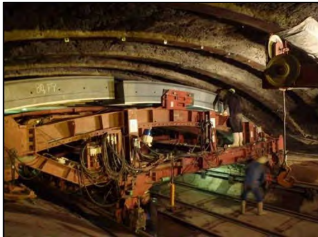
上半拡幅セグメント組立 上半拡幅セグメント組立装置
