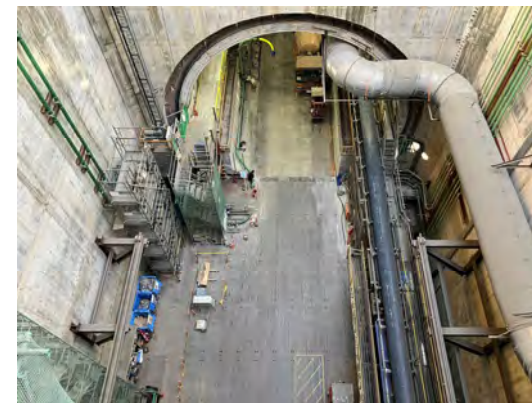
発進立坑部の状況 (令和6年11月25日)
