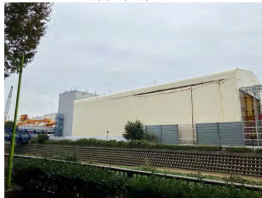
土砂ピットヤードの状況(野川側から望む) (令和6年11月14日)
