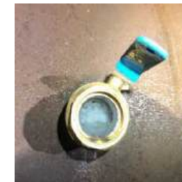
止水対策後の状況
