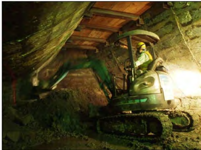
下半中央部掘削 油圧ショベル【低騒音型・低振動型】
