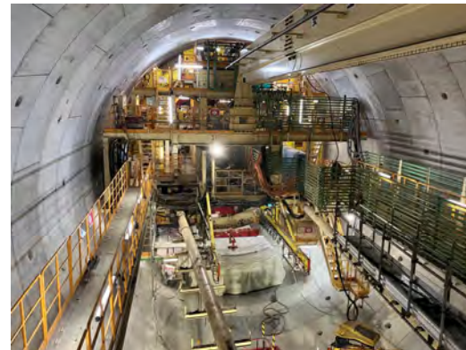
シールドマシンの状況 (令和6年11月1日)
