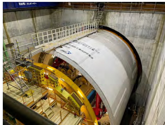
シールドマシン発進前の状況 (令和4年12月9日)
