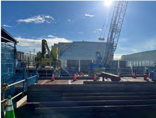
Hランプ工事 水道道路付近から南方向を望む (令和6年11月27日)
