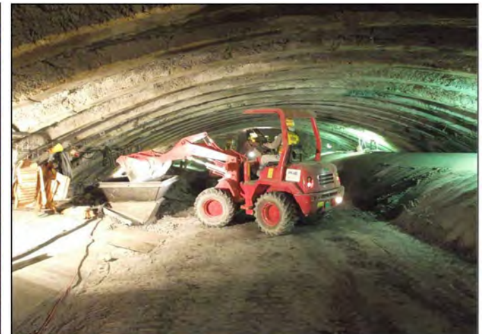
上半掘削土搬出 ホイールローダー
