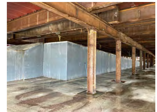
Hランプ函体構築の状況 (令和6年8月28日)
