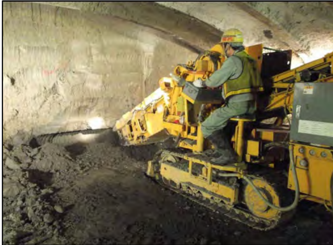
上半中央部掘削 自由断面掘削機(カッターローダー)
