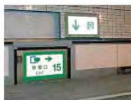
路面下への非常口(路面から)
