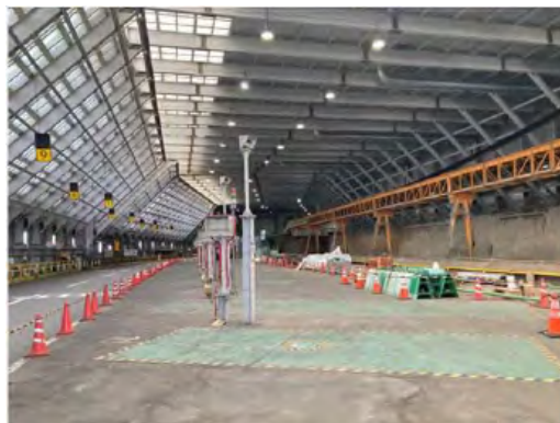
土砂ピットヤードの内部状況 (令和6年12月11日)
