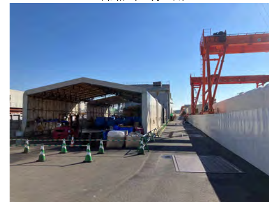
セグメントストックヤードの状況 (令和6年11月22日)
