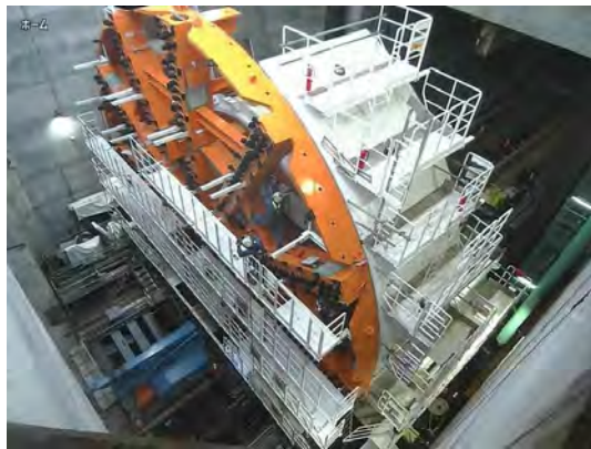
シールドマシンの組立状況 (令和2年9月25日)
