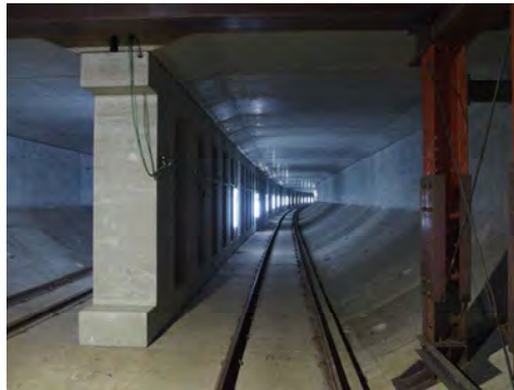
内部構築工・仮設床版の状況 (令和6年12月5日)
