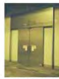
首都高速中央環状新宿線の例
