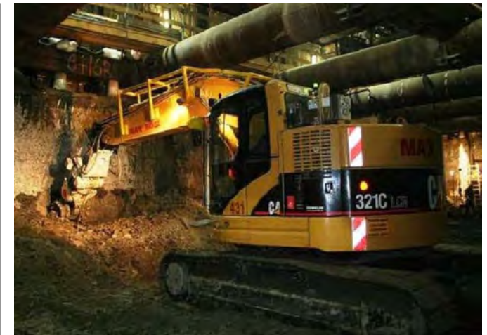
地山掘削・吹付けコンクリート撤去 自由断面掘削機(ドラムカッター)
