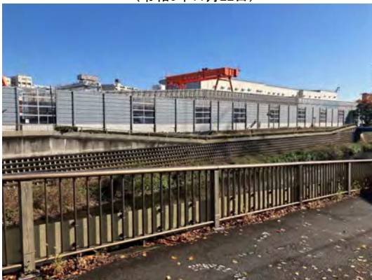
土砂ピットヤードの状況(野川側から望む) (令和6年11月22日)
