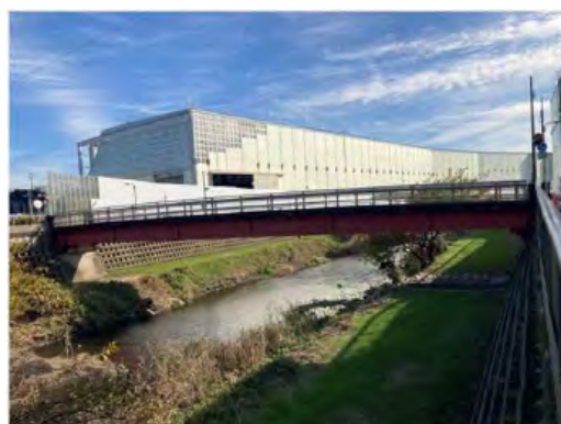
土砂ピットヤードの全景写真 (令和6年12月11日)
