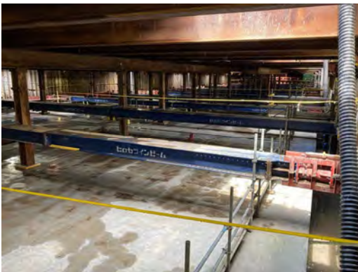
Hランプ函体構築の状況 (令和6年8月28日)
