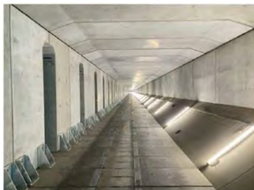
内部構築工の状況 (令和6年12月11日)
