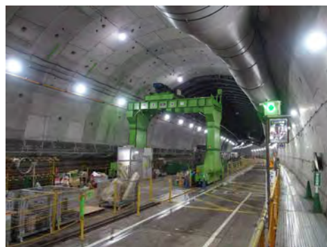
トンネル内の資材投入設備の状況 (令和6年12月5日)
