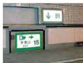
路面下への非常口(路面から)
