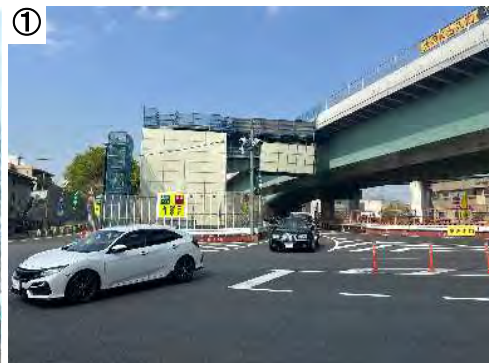
送出し架設前 (令和5年4月)
