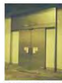
首都高速中央環状新宿線の例
