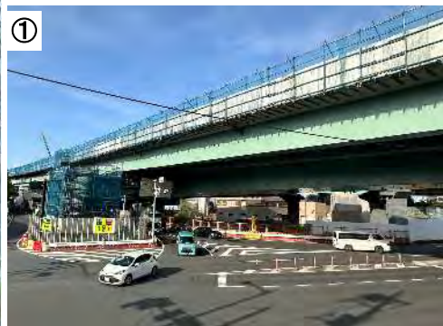
送出し架設後 (令和6年4月)
