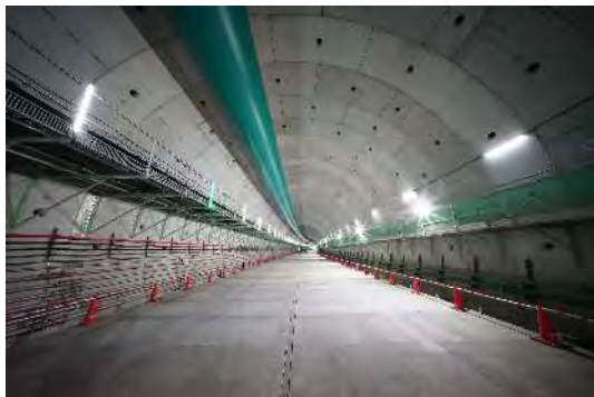
床版構築状況 (令和5年11月21日)
