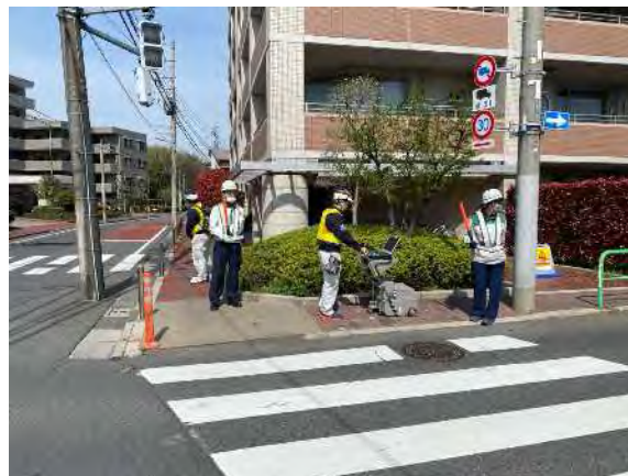
路面下空洞調査(歩道部)
