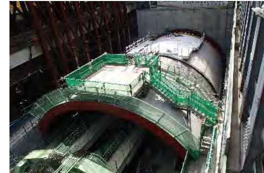
シールドマシン組立完了状況 (平成31年1月27日)
