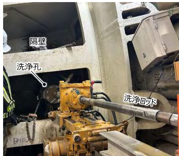
高圧洗浄の作業状況
