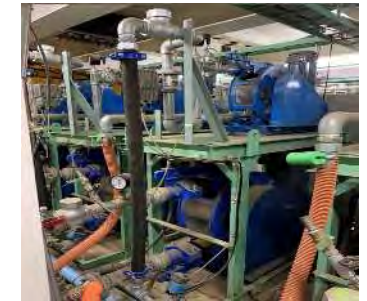
添加材注入ポンプ
