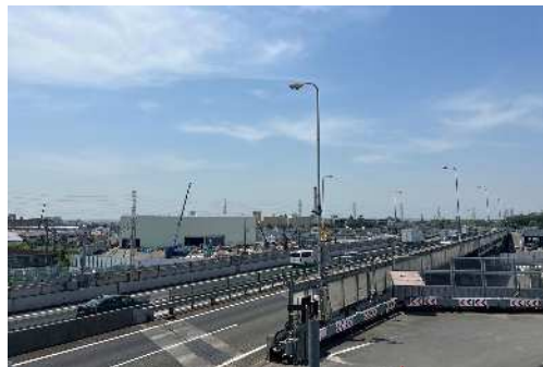
中央JCT上り線ONランプ工事用仮橋の状況 (令和5年5月18日)
