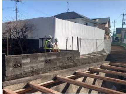
変状調査(測量)
