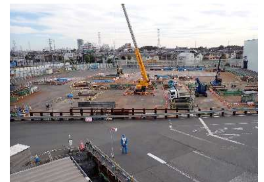
中央JCT南側開削トンネル施工状況(地上部) (令和7年11月12日)
