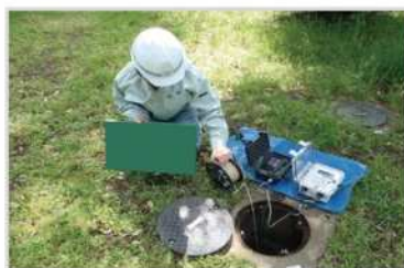
地下水位の観測状況
