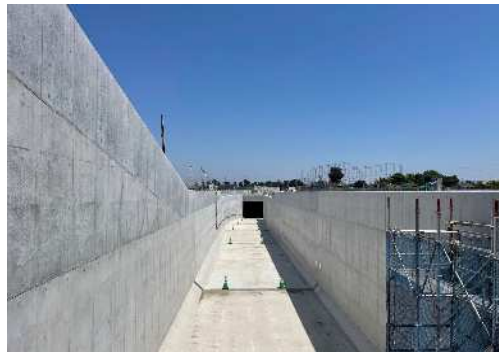
中央JCT北側開削トンネル施工状況 (令和5年5月16日)
