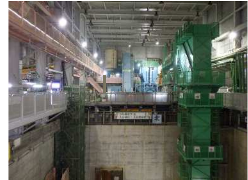
防音ハウス内の状況 (令和7年11月27日)
