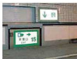
路面下への非常口(路面から)
