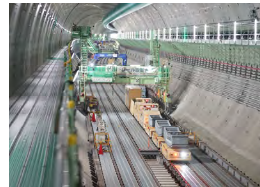
セグメント搬送状況 (令和7年11月13日)
