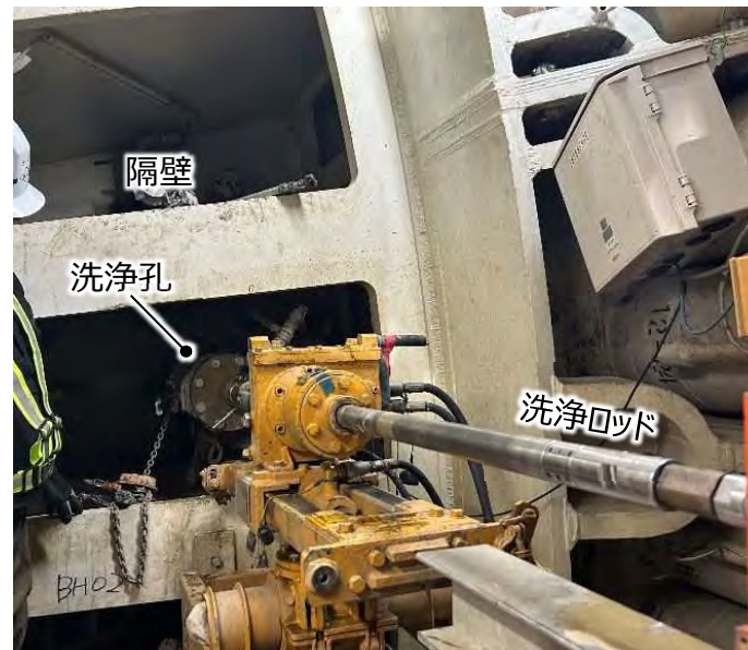
高圧洗浄の作業状況
