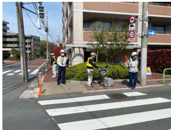
路面下空洞調査(歩道部)
