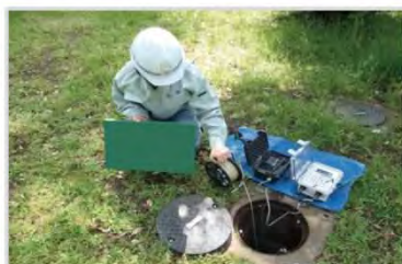
地下水位の観測状況
