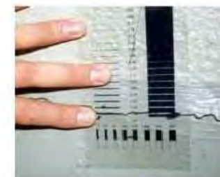
例: 亀裂損傷調査
