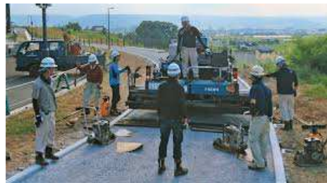
■道路に舗装を行います
