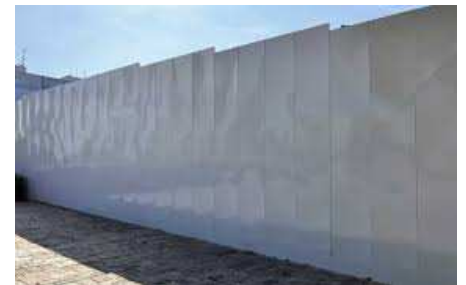
■道路開放前に工事範囲との境界に工事用パネルを設置します
