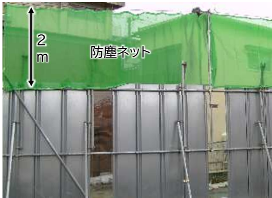
防塵ネット(高さ2.0m)
