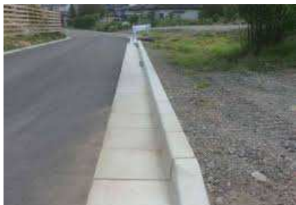
■道路に降った雨水を排水する設備を設置します
