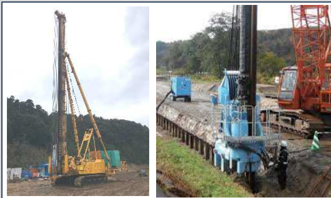
地中の土留壁を造成する機械
