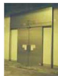
首都高速中央環状新宿線の例
