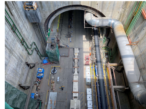
発進立坑部の状況 (令和6年5月15日)
