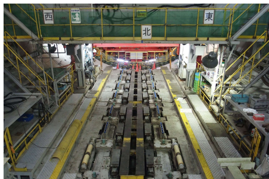
セグメントを供給する装置の状況 (令和6年4月25日)
