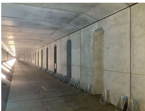
内部構築工の状況 (令和6年5月30日)
