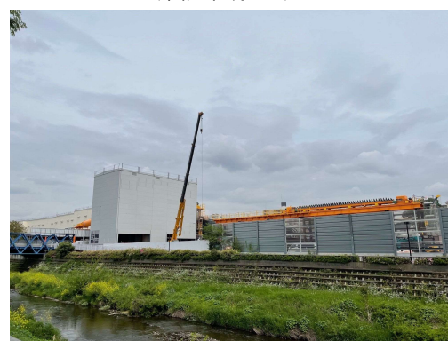
土砂ピットヤードの状況 (野川側から望む) (令和6年4月18日)
