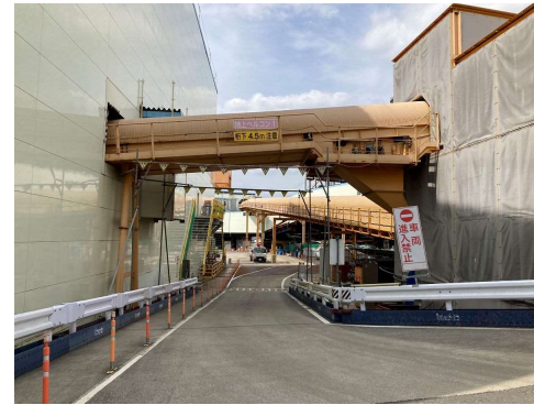
立坑地上部・連続ベルコントコンベア (令和6年4月11日)
