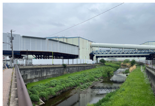
土砂ピットヤードの全景写真 (令和6年4月25日)
