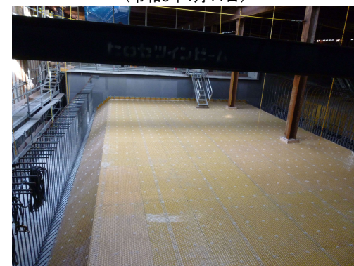
Hランプ函体構築の状況 (令和5年5月18日)
