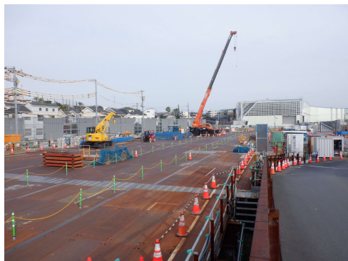
Hランプ工事 水道道路付近から南方向を望む (令和6年4月11日)
