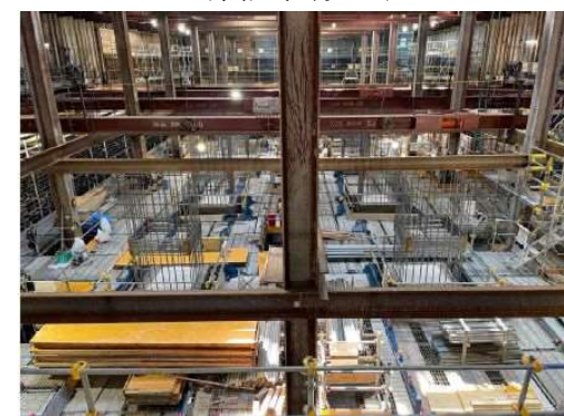
換気所地下構造物の立坑内の状況(床付け) (令和6年4月11日)
