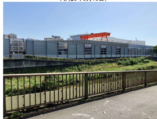
土砂ピットヤードの状況（野川側から望む） (令和6年5月17日)
