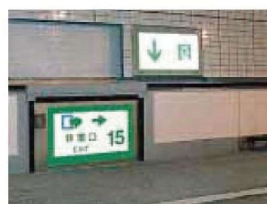
路面下への非常口(路面から)
