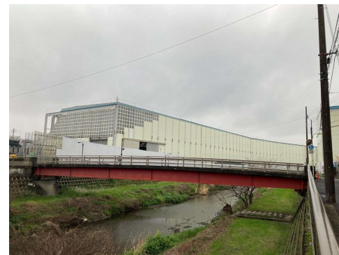
土砂ピットヤードの全景写真 (令和6年3月26日)
