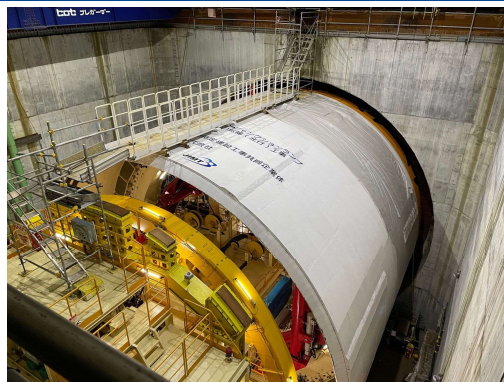
シールドマシン発進前の状況 (令和4年12月9日)
