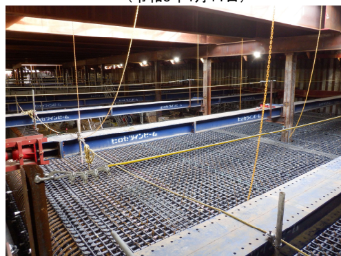
Hランプ函体構築の状況 (令和6年4月11日)
