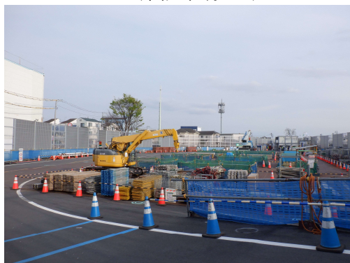
換気所地下工事の状況(地上部) (令和6年4月11日)
