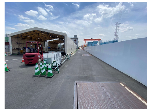
セグメントストックヤードの状況 (令和6年5月15日)
