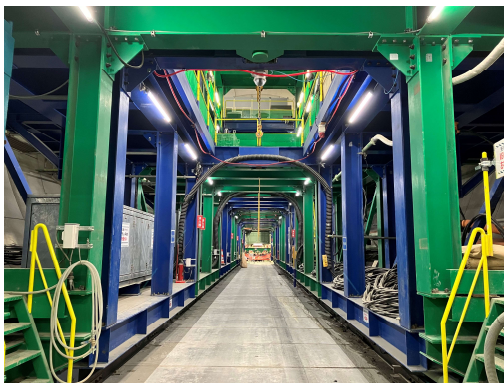
シールドマシン後続台車の状況 (令和6年5月17日)
