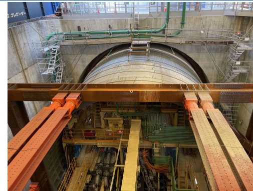
発進立坑部の状況 (令和6年4月18日)
