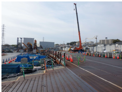
Hランプ工事 大正橋付近から北西方向を望む (令和6年4月11日)
