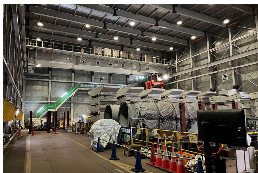
セグメントストックヤードの状況 (令和6年4月25日)
