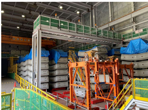
セメントストックヤードの状況 (令和6年4月11日)
