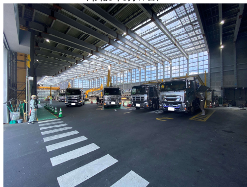
土砂ピットヤードの内部状況 (令和6年5月15日)
