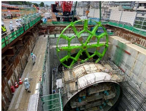
シールドマシンの組立状況 (令和3年6月21日)
