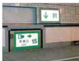
路面下への非常口(路面から)
