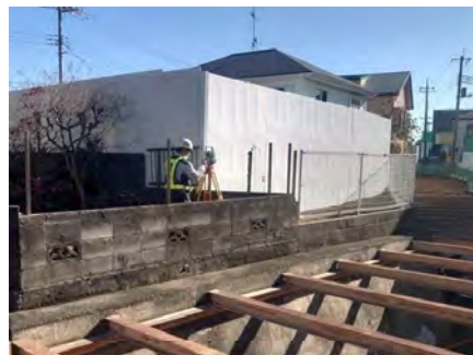
変状調査(測量)
