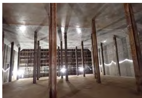
中央JCT南側開削トンネル施工状況 (令和5年12月20日)
