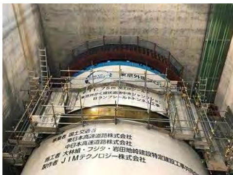
シールドマシン発進前の状況 (令和5年1月20日)
