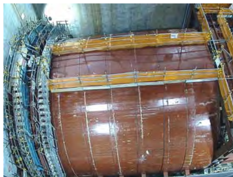
発進立坑部の状況 (令和6年11月20日)
