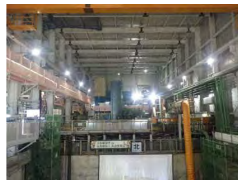
防音ハウス内の状況 (令和6年11月29日)
