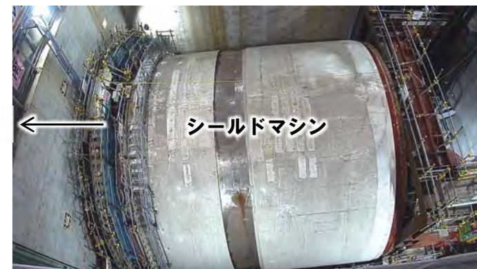
発進立坑部の状況 (令和6年9月18日)
