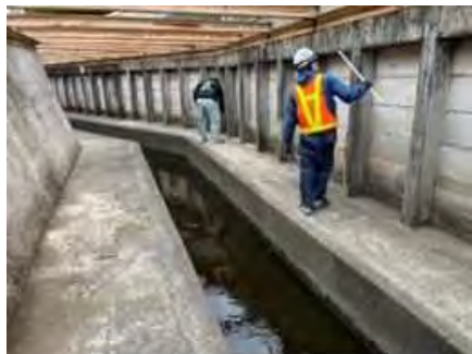
変状調査(点検)
