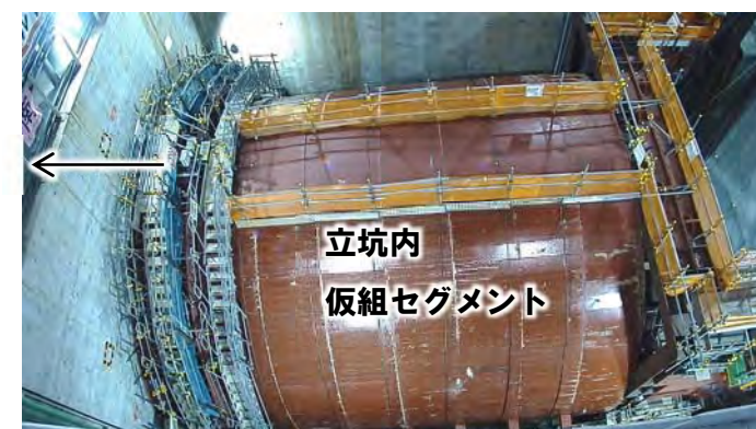
発進立坑部の状況 (令和6年11月20日)
