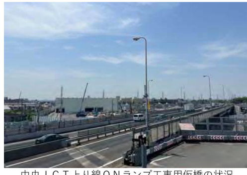
中央JCT上り線ONランプ工事用仮橋の状況 (令和5年5月18日)
