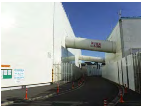
ベルトコンベアの状況 (令和6年11月29日)
