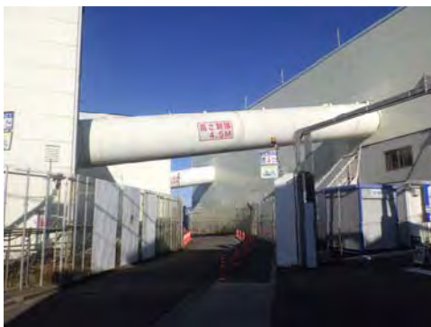
ベルトコンベアの状況 (令和6年11月29日)
