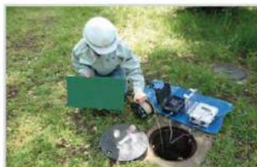
地下水位の観測状況
