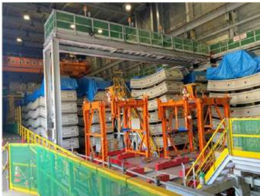
セグメントストックヤードの状況 (令和6年12月11日)
