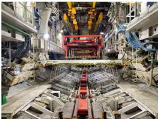
切羽付近のシールドマシンの状況 (令和6年12月11日)
