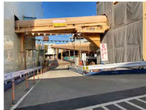
立坑地上部・連続ベルコトコンベア (令和6年12月11日)
