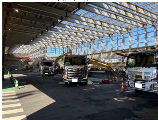
土砂ピットヤードの内部状況 (令和6年11月22日)
