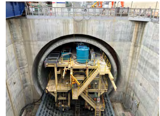
発進立坑部の状況 (令和6年11月1日)
