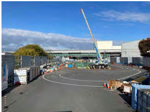
換気所地下工事の地上部 左岸野川下流部から望む (令和6年11月27日)
