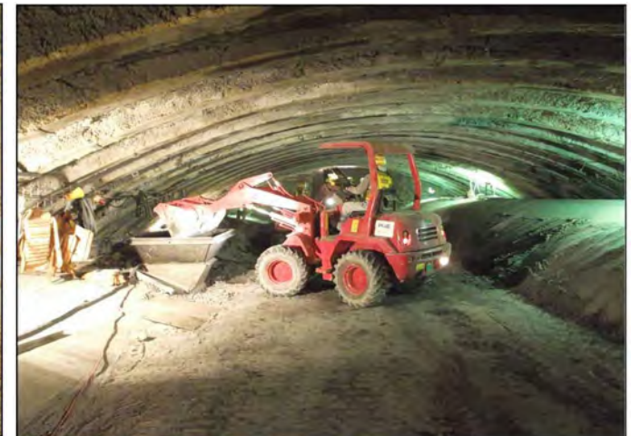
上半掘削土搬出 ホイールローダー
