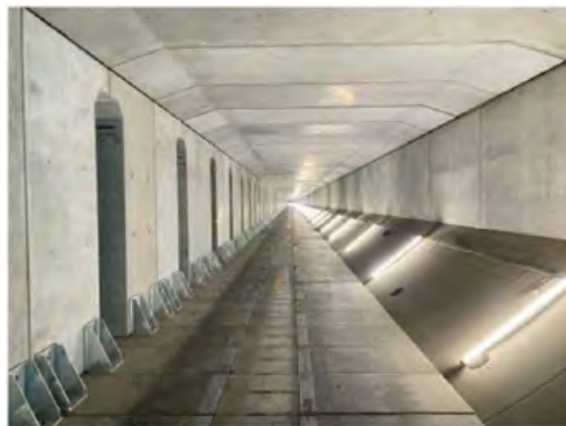
内部構築工の状況 (令和6年12月11日)
