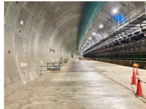
トンネル内の状況 (令和6年12月11日)
