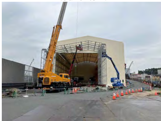
土砂ピットヤードの設置状況 (令和6年11月14日)
