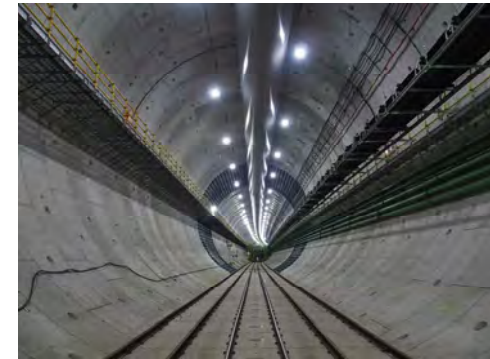
トンネル内の状況 (令和6年12月5日)
