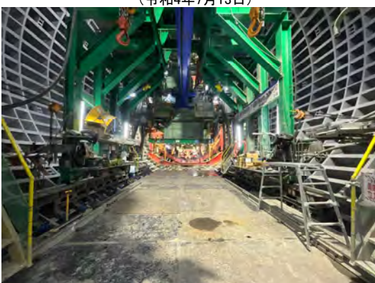
シールドマシン後方の状況 (令和6年11月22日)
