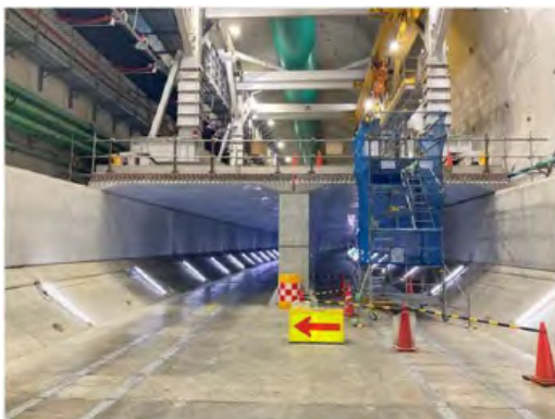
内部構築工・床版設置状況 (令和6年12月11日)
