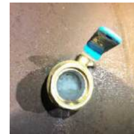
止水対策後の状況
