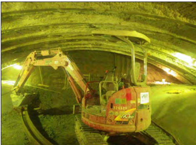
鋼アーチ支保工設置 油圧ショベル【低騒音型・低振動型】
