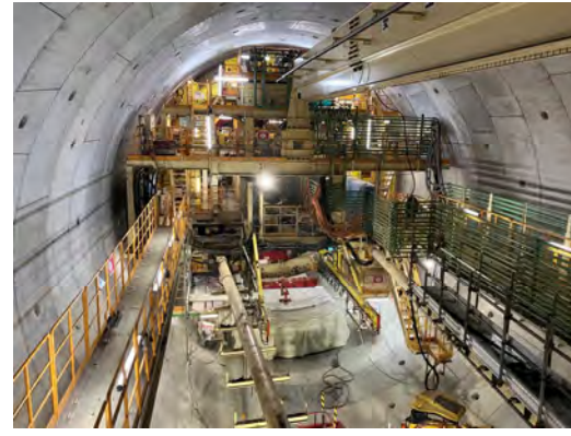
シールドマシンの状況 (令和6年11月1日)
