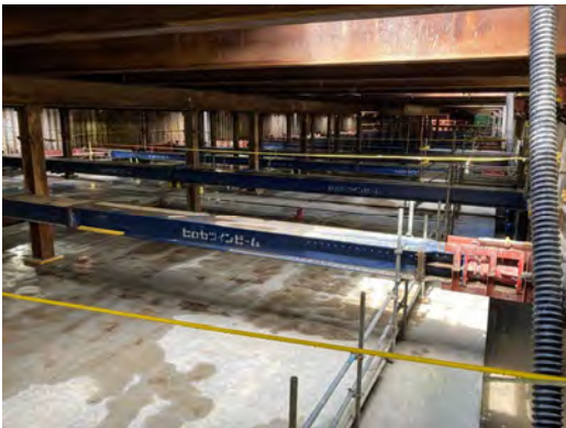
Hランプ函体構築の状況 (令和6年8月28日)
