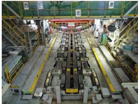
セグメントを供給する装置の状況 (令和6年12月5日)
