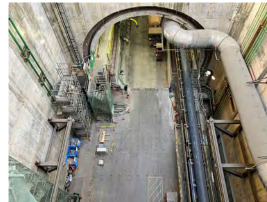
発進立坑部の状況 (令和6年11月25日)
