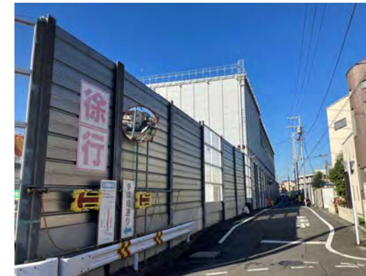
土砂ピットヤードの状況(世田谷通り方面から望む) (令和6年11月22日)
