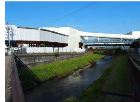
土砂ピットヤードの全景写真 (令和6年12月5日)
