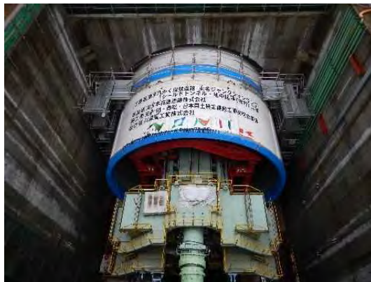
シールドマシン発進前の状況 (令和4年7月13日)
