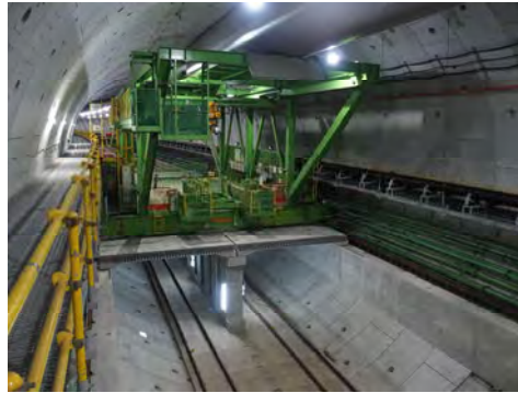
トンネル内の内部構築施工設備の状況 (令和6年12月5日)
