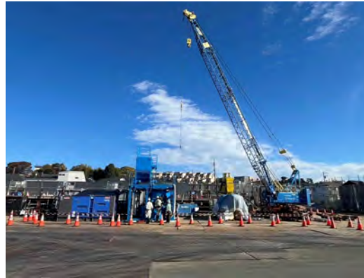
Hランプ工事 大正橋付近から北西方向を望む (令和6年11月27日)
