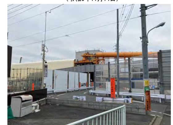
土砂ピットヤードの状況(世田谷通り方面から望む) (令和6年11月14日)
