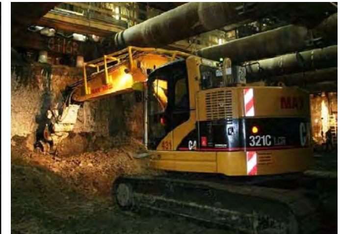
地山掘削・吹付けコンクリート撤去 自由断面掘削機(ドラムカッター)
