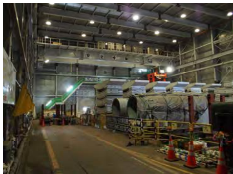
セグメントストックヤードの状況 (令和6年12月5日)
