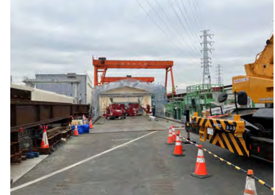
セグメントストックヤードの状況 (令和6年11月14日)
