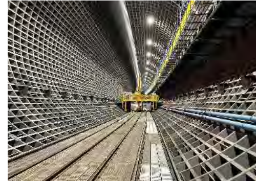
構築されたトンネル内(鋼製セグメント) (令和7年7月25日)
