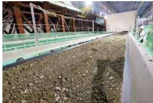
掘削した土砂をベルトコンベヤーで搬送する状況 (令和5年12月21日)
