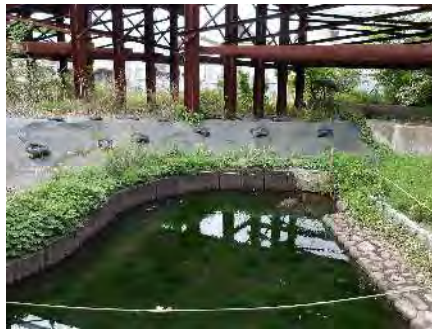
土砂流入防止措置の状況(R7.4)
