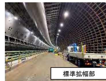
東名JCT地中拡幅(南行)の現地の状況
