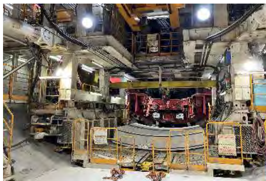
掘進状況 (令和7年7月25日)
