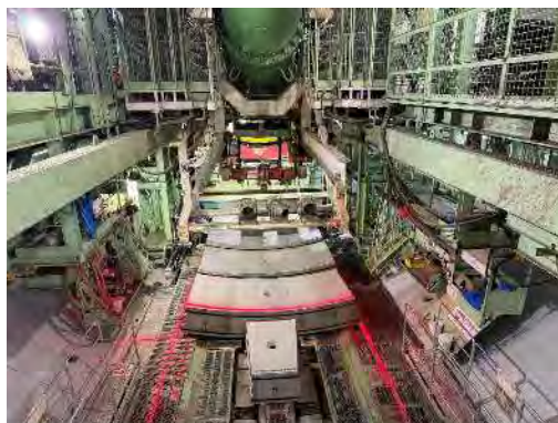
セグメント組立状況 (令和7年7月25日)
