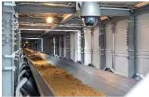
掘削した土砂をベルトコンベヤーで搬送する状況 (令和元年9月18日)
