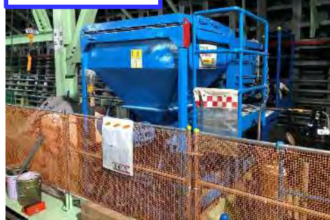
滑剤充填設備(大泉本線(北行)シールドトンネル工事の実績)
