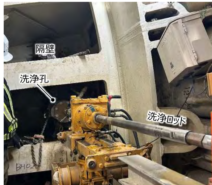
高圧洗浄の作業状況
