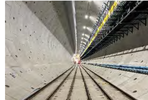
構築されたトンネル内(RCセグメント) (令和7年7月25日)
