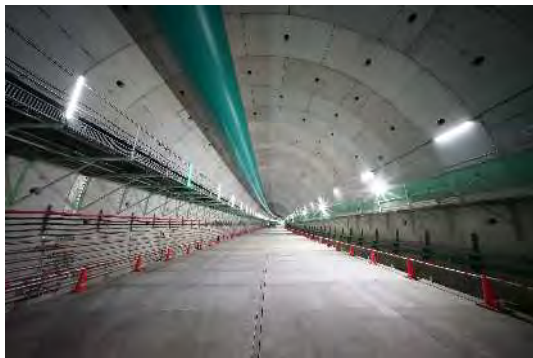
床版構築状況 (令和5年11月21日)
