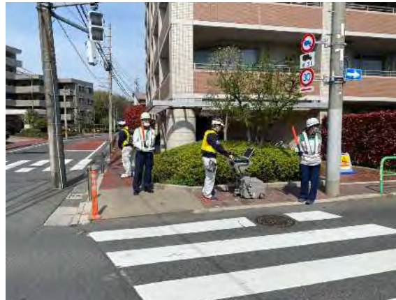
路面下空洞調査(歩道部)
