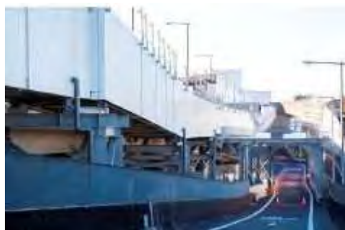
外環道のベルトコンベヤーの設置が完了した状況 (令和元年5月14日)
