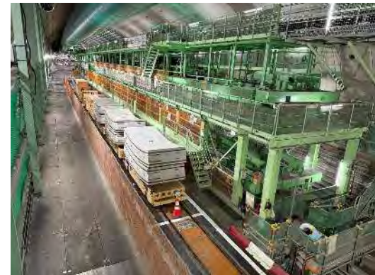
セグメント搬送状況 (令和7年7月25日)
