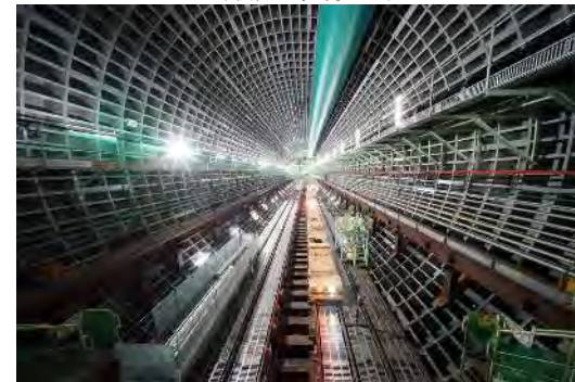
構築されたトンネル内(鋼製セグメント) (令和7年7月25日)
