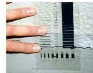
例: 亀裂損傷調査
